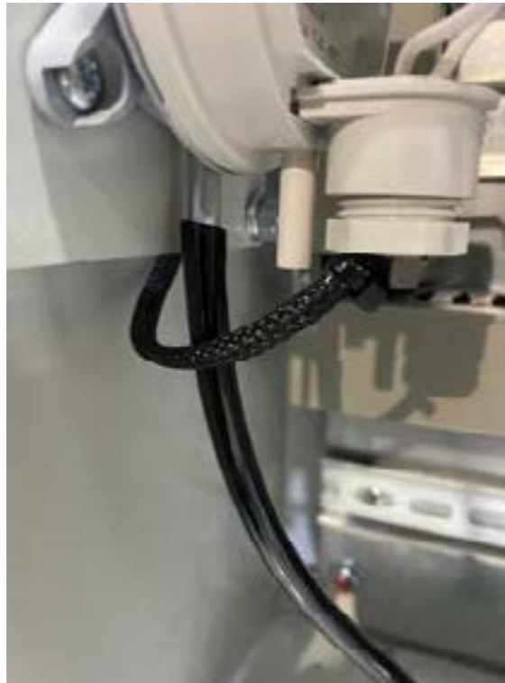
Détails du pressostat
